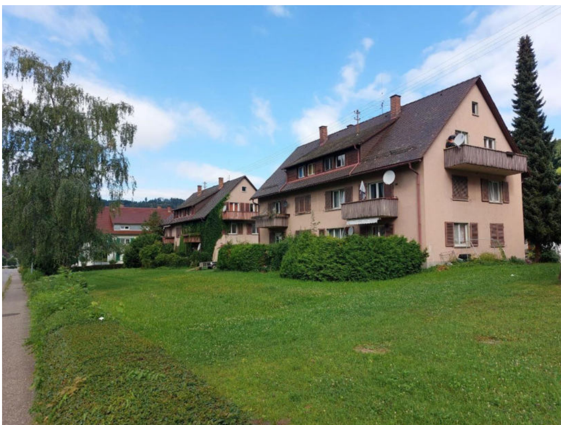
Abbildung 1 Von der Wasen zur Baufläche, Blickrichtung Nordwesten
