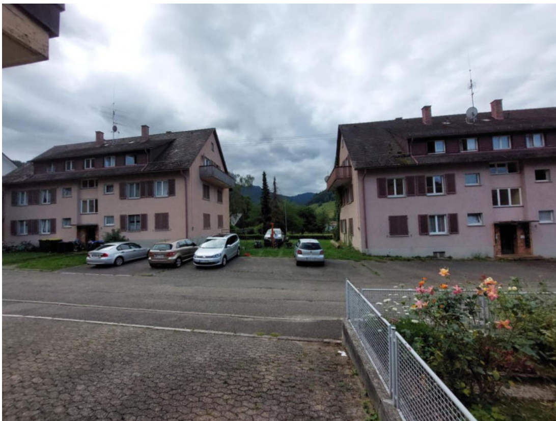
Abbildung 2 Vom Erwin-Pfefferle-Weg zur Baufäche, Blickrichtung Süden
