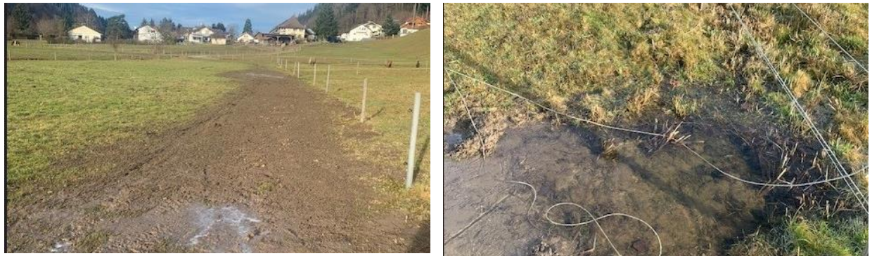
Abbildung 3-3: Ausführende Arbeiten im Zuge der Kompensationsmaßnahme „Entwicklung einer Nasswiese“ (Fotos ORTLIEB 2026)
