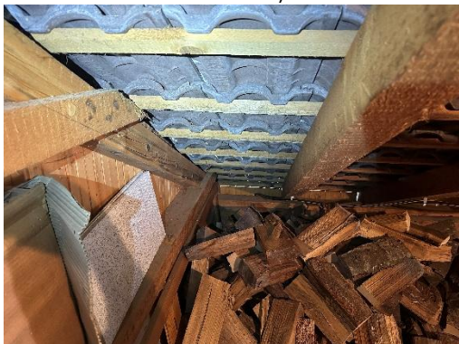
Bild 11: Innenraum des Dachstuhls in der Doppelgarage (H. Röske, 27.05.2025)
