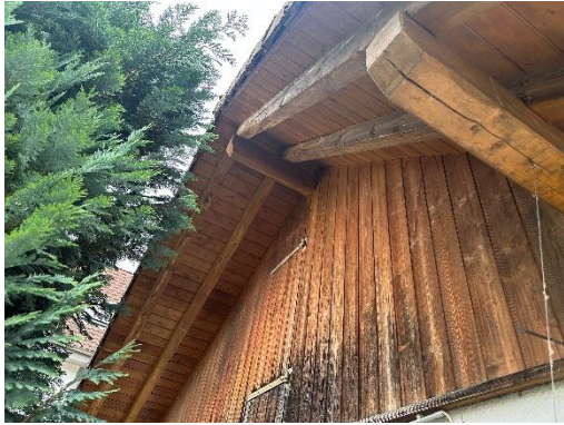
Bild 7: Nördlicher Dachstuhl der (H. Röske, 27.05.2025)
