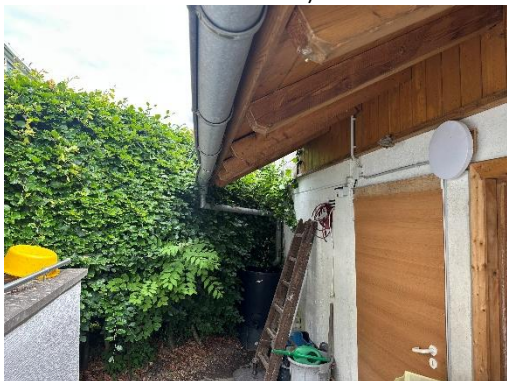
Bild 5: Östliche Fassade der Doppelgarage (H. Röske, 27.05.2025)
