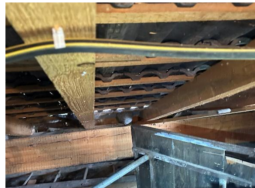
Bild 12: Innenraum des Dachstuhls in der Doppelgarage (H. Röske, 27.05.2025)
