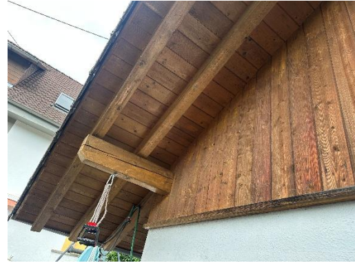
Bild 8: Nördlicher Dachstuhl Doppelgarage (H. Röske, 27.05.2025)
