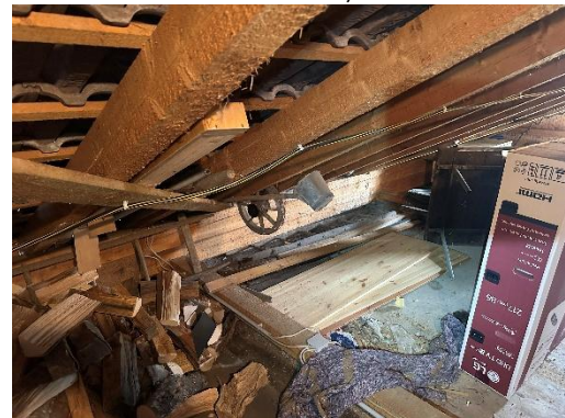
Bild 10: Innenraum des Dachstuhls in der Doppelgarage (H. Röske, 27.05.2025)
